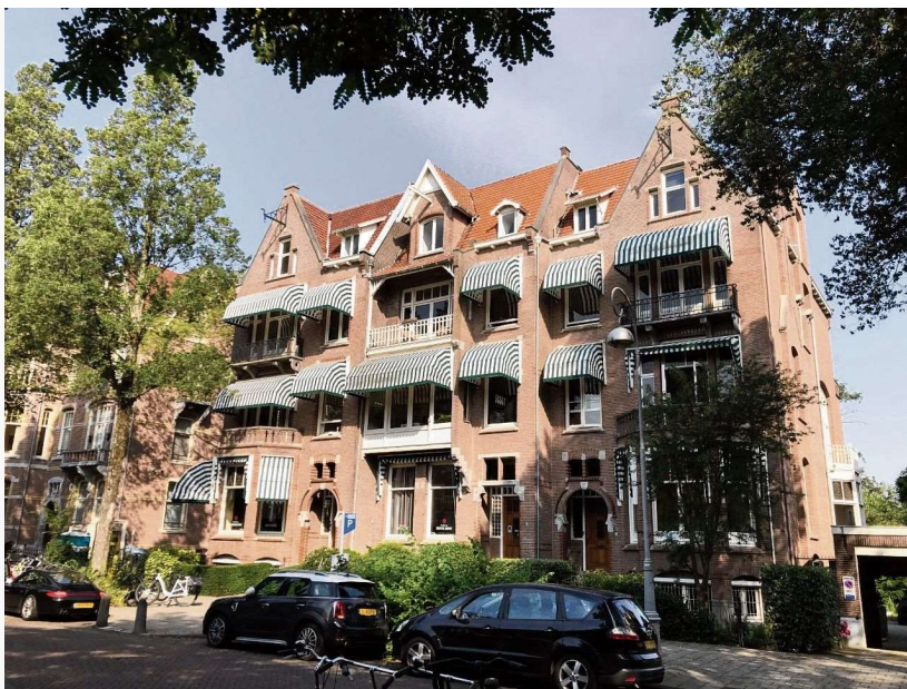
De bewuste panden in de Van Eeghenstraat waar een parkeergarage onder moet komen. Foto Maarten Eliasar
