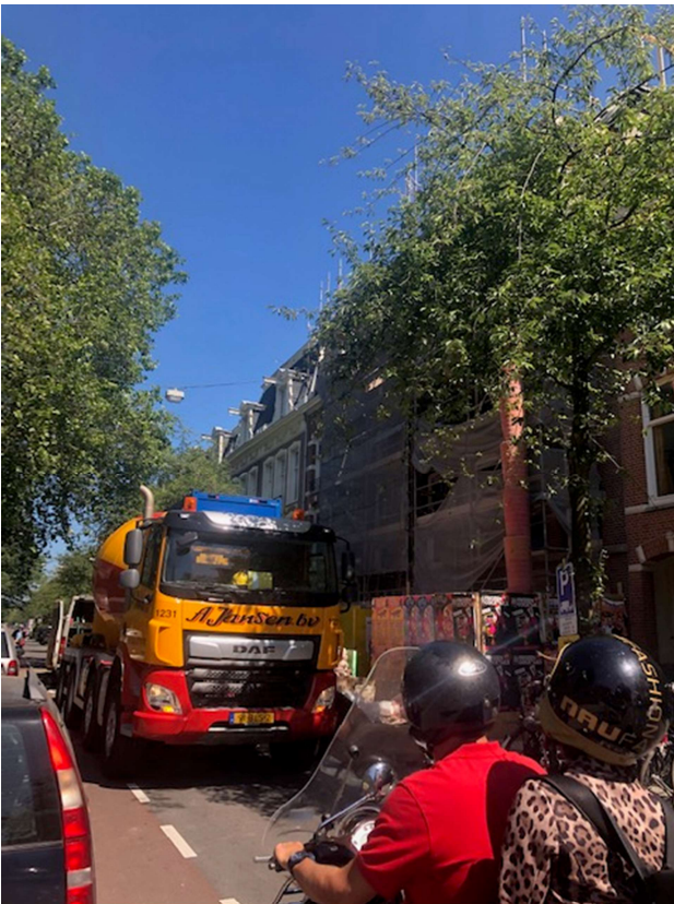
Figuur 1 Blokkade door bouwverkeer
